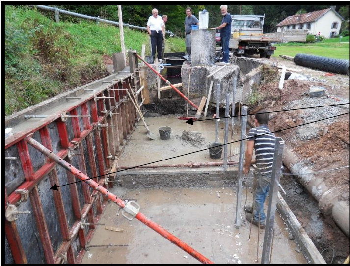
Réalisation de la dalle de fond et des murs porteurs.
